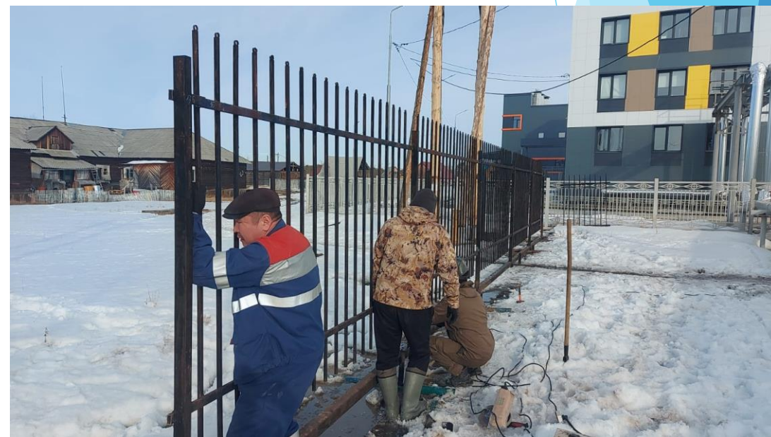
Ремонт ограждения территории силами коллектива мужчин
