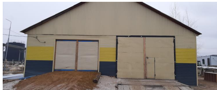
Здание мастерской 1980 г.п. Проведен ремонт в 2022 году. Используется в качестве гаража
